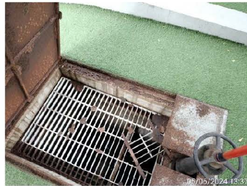
ตะแกรงดักมูลฝอยที่บ่อพักน้ำสุดท้าย
