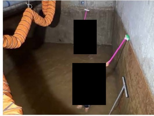
การทำความสะอาดถังสำรองน้ำใช้
