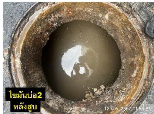
การสูบน้ำก่อนและไขมันระบบบำบัด
