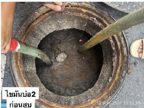
การสูบน้ำก่อนและไขมันระบบบำบัด
